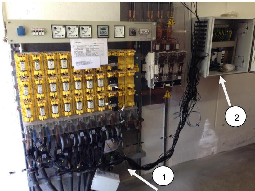
**Abbildung 5: Mobil einsetzbares Messsystem der Fa. WAGO Kontakttechnik 1) Umbauwandler zur Strommessung und Spannungsabgriffe 2) Kommunikationstechnische Anbindung ans eigene Glasfasernetz**
