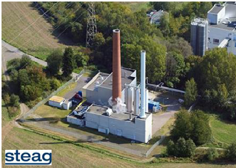
Abbildung 1: Heizkraftwerk Wellesweiler der STEAG New Energies GmbH
